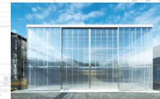
カモ井加工紙mt倉庫新築工事
