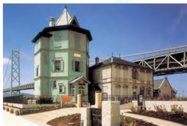
2000 重要文化財 移情閣 移築
