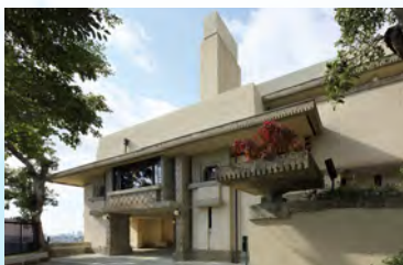
2018 重要文化財 旧山邑家住宅 修復
